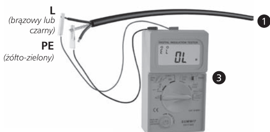
Pomiar rezystancji izolacji
